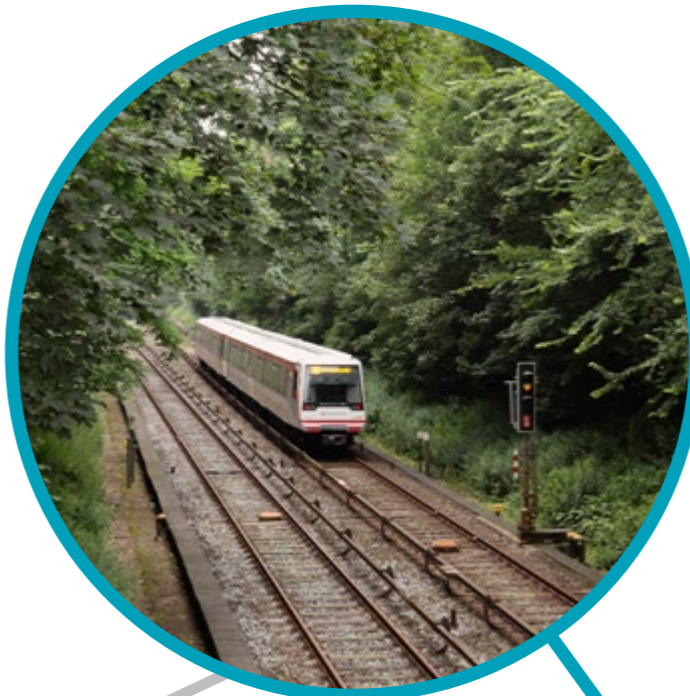
Die U4 bedient fünf Haltestellen inmitten der Landschaftsachse. Zwischen U-Bahn Burgstraße und Hammer Kirche verläuft sie auf einer tiefer gelegenen Strecke.
